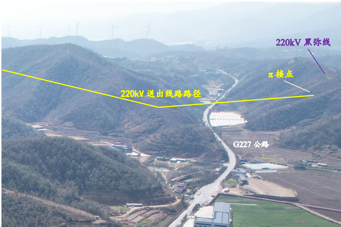
220kV 送出线路末段
