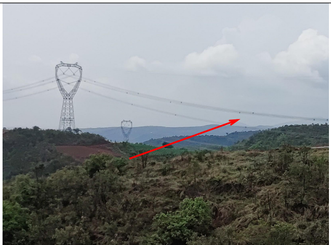
穿越 500kV 仁厂乙线
