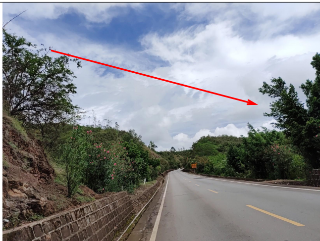
跨越永南二级公路
