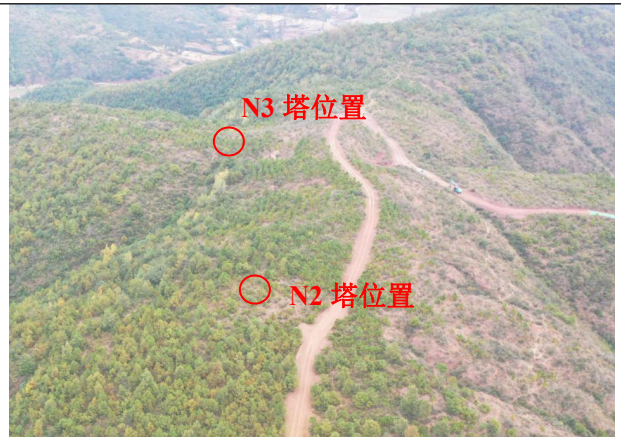
N2 塔、N3 塔现状照片
