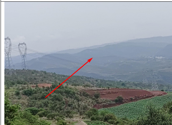
穿越 500kV 仁昆甲乙线
