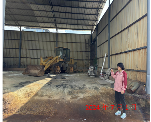
现场踏勘现状照片
