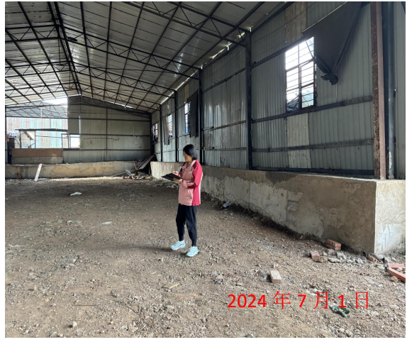
现场踏勘现状照片
