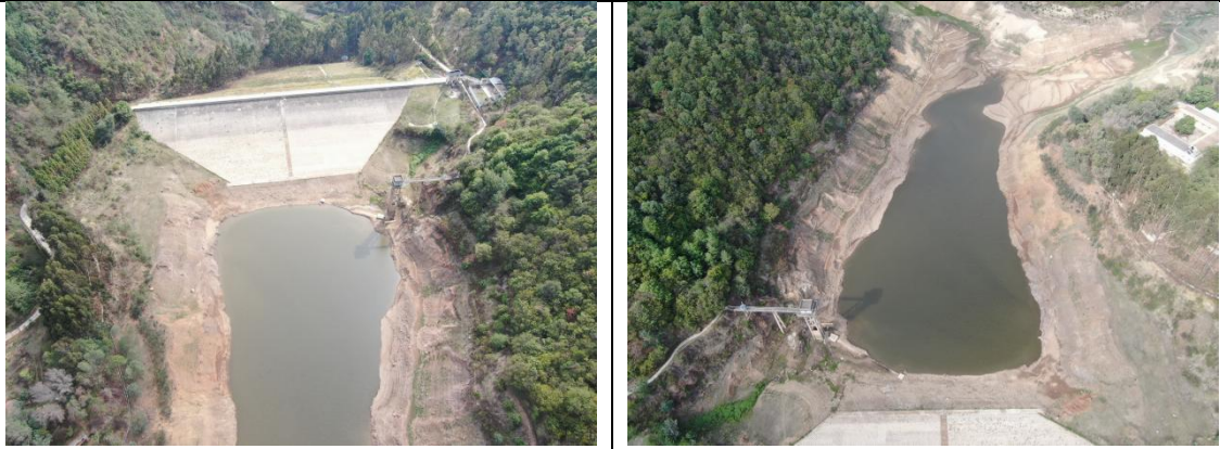
拟建 110kV 线路周边大冲箐水库现状
