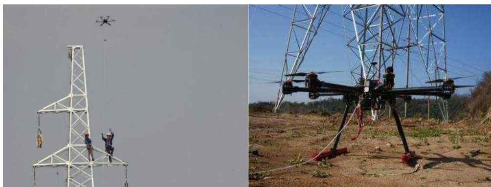
图 2-9 无人机展放导引绳施工工艺
