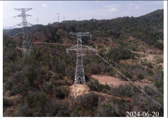
N3 塔建设情况
