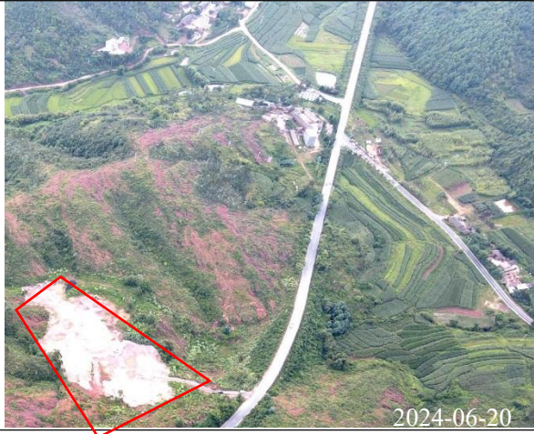
110kv 孔家庄升压站
