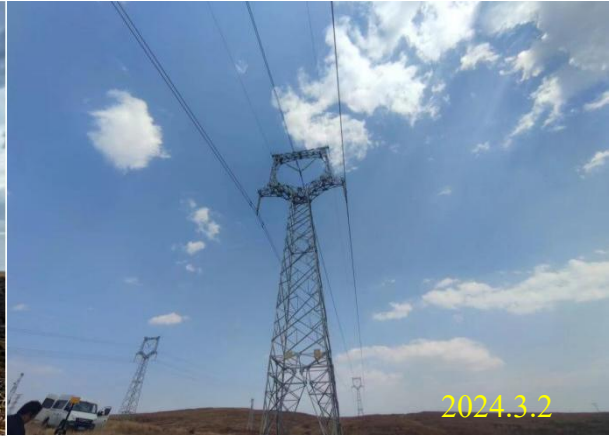
跨越 220kV 线路
