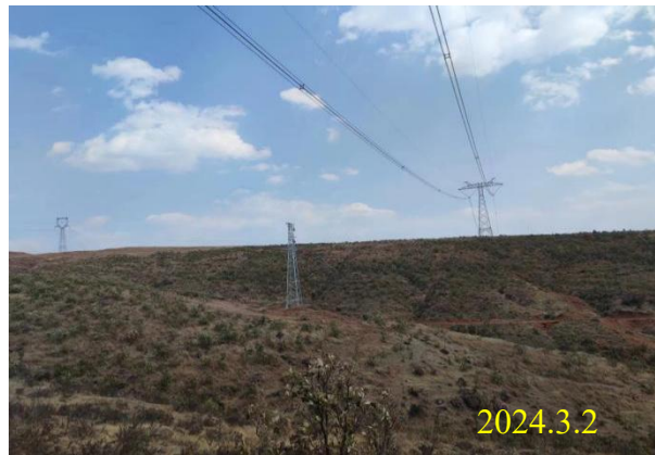
跨越 500kV 线路
