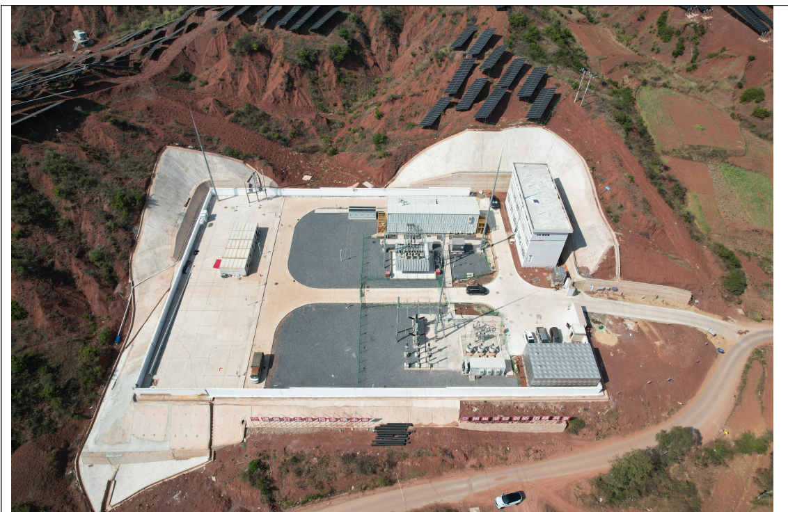
起点鲁家菁光伏电站 110kv 升压站
