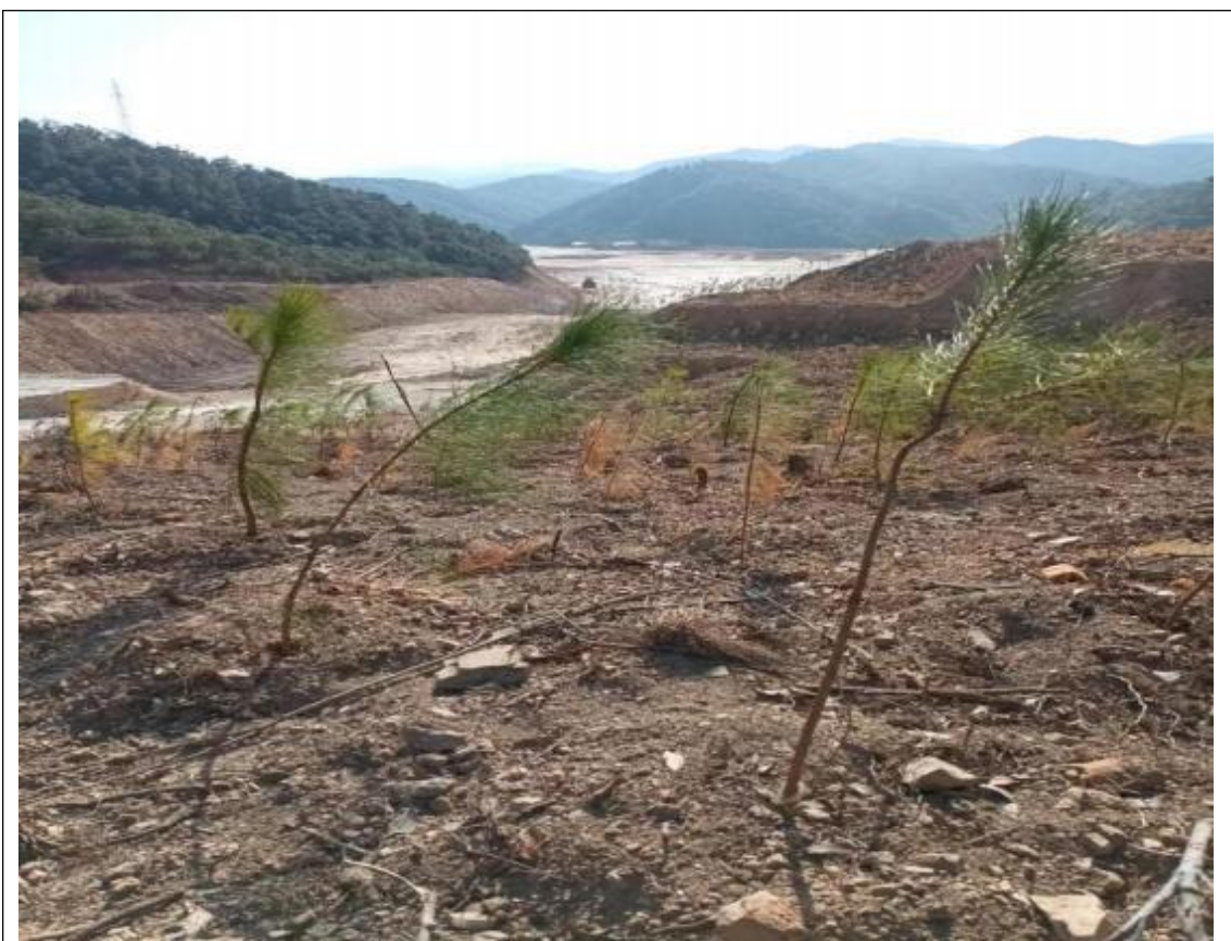
临时施工场地植被恢复现状
