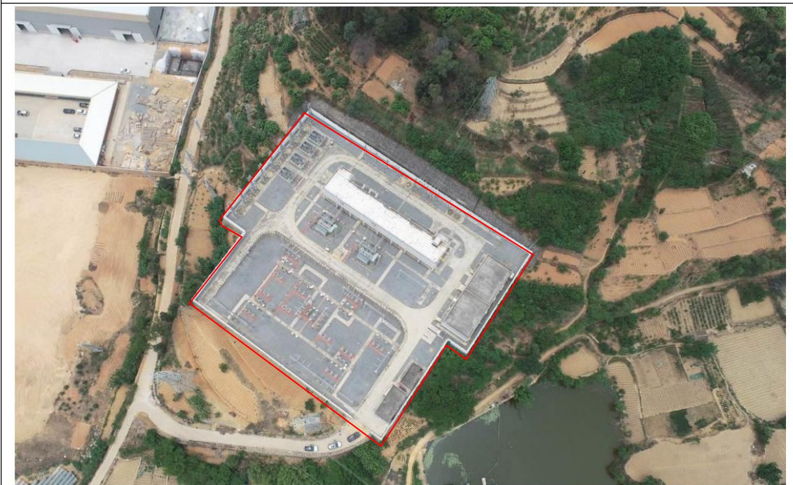
终点 110kv 指挥营变电站
