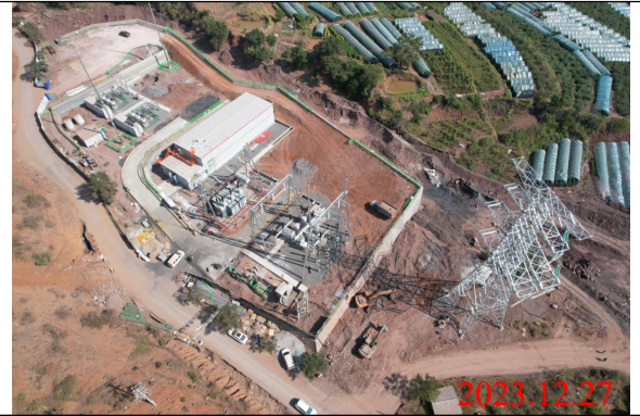
升压站建设现状
