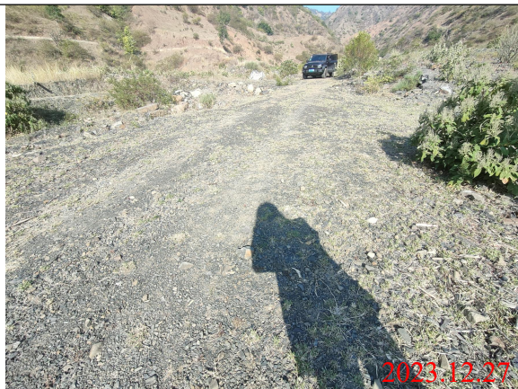
光伏区入场道路现状
