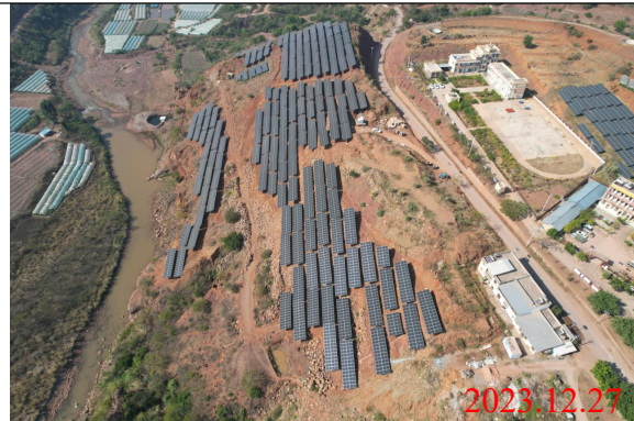
4#光伏发电区（已批已建设地块、局部）
