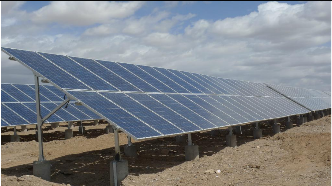
图2-2 固定支架太阳能方阵
