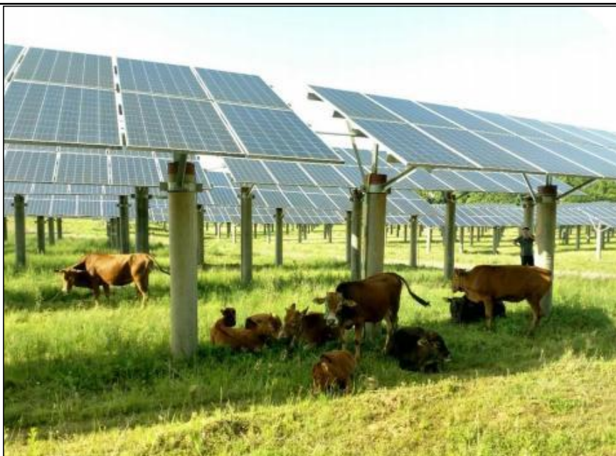
图 4-3 牧光互补示意图
