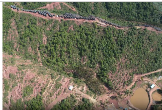
南片区红星坝水库东南面已建成的光伏阵列
