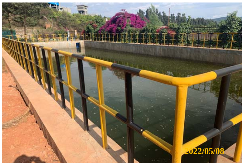
1300m 3 初期雨水收集池
