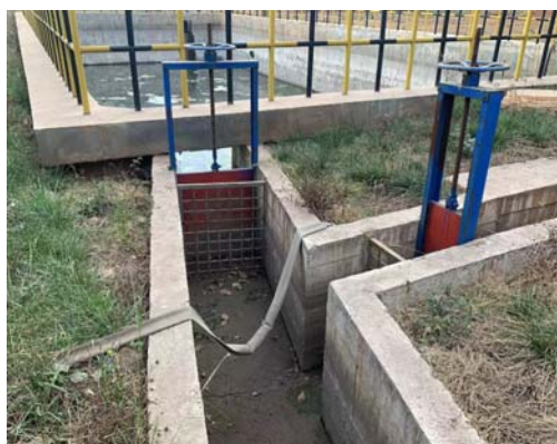
图4.3-2 事故池和初期雨水收集池沟渠联通现场照片
