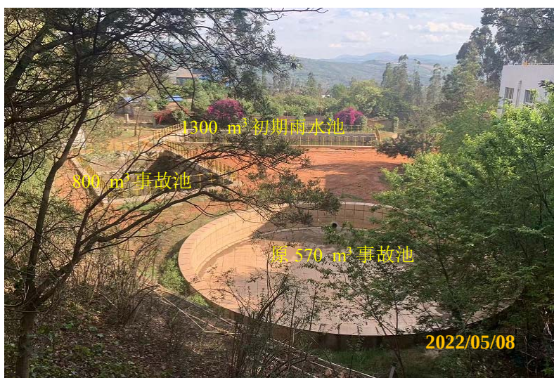
事故池、初期雨水收集池整体
