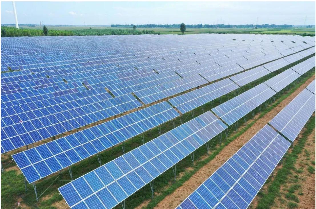
图 2-2 固定支架太阳能方阵示意图
