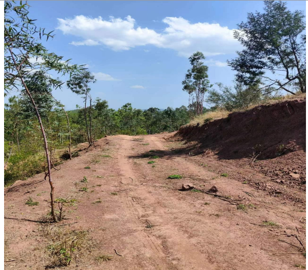
项目中部开关站进场道路现状
