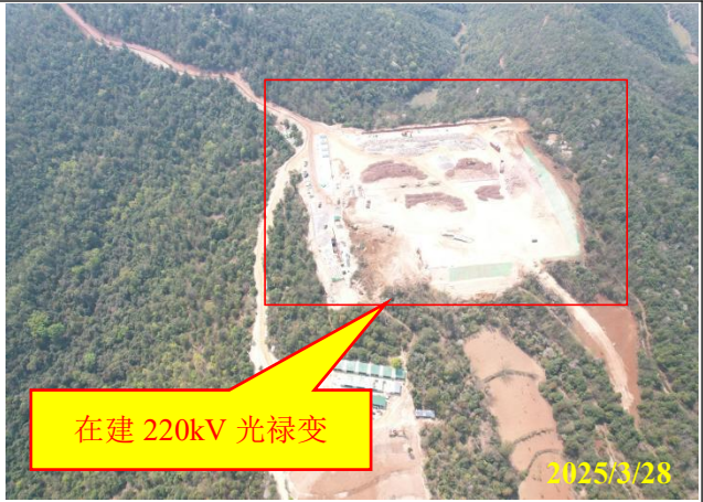
图 2 在建 220kV 光禄变电站（线路终点）
