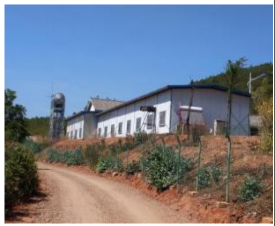
项目厂址东北侧化工园区指挥部
