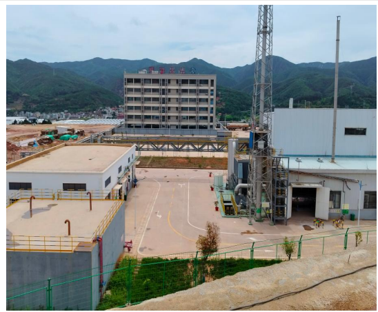
项目西侧鑫盛能源
