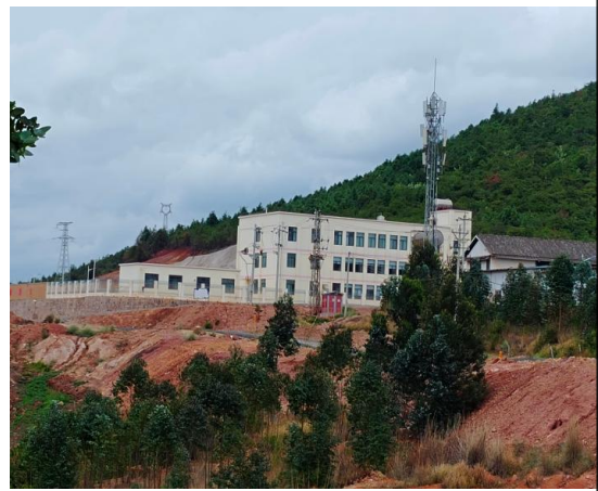
厂址东北侧天然气门站
