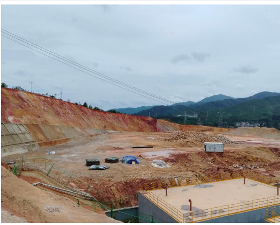
项目厂址西南侧兰洁拟建场地
