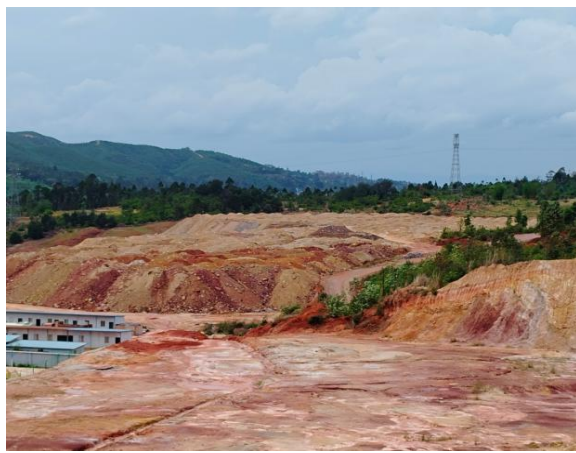
项目厂址西北侧正在平整园区土地
