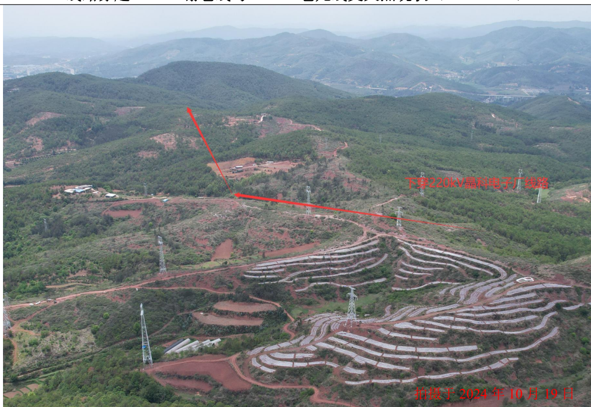
线路穿越 220kV 晶科电子厂线交叉点现状 (N43~N44~N45)
