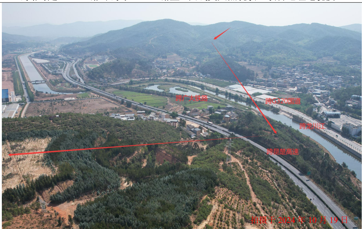
线路跨越昆楚高速、广大铁路、龙川江、G320 国道点现状（N64~N66）
