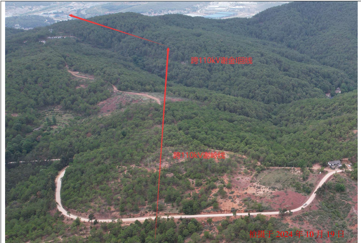
线路跨越 110kV 谢岭线与 110kV 谢金 I 回线交叉点现状（项目地理电缆段）
