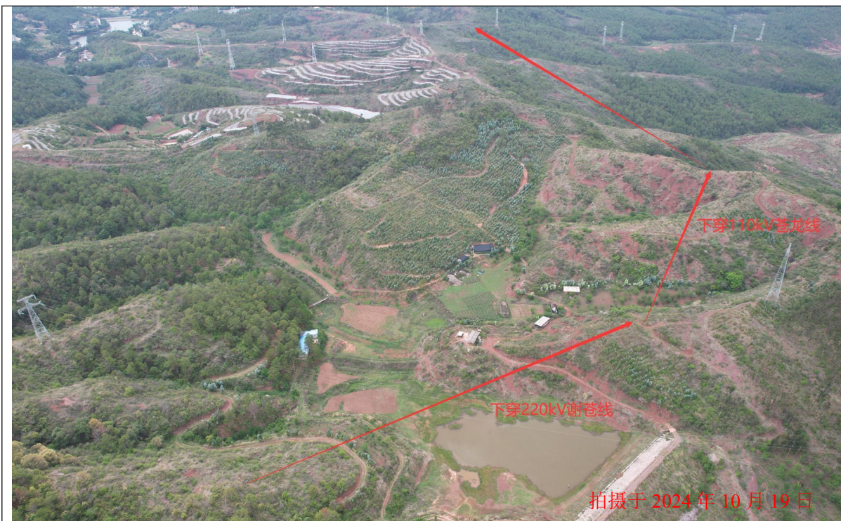
线路穿越 220kV 谢苍线与 110kV 苍龙线交叉点现状 (N40~N41)
