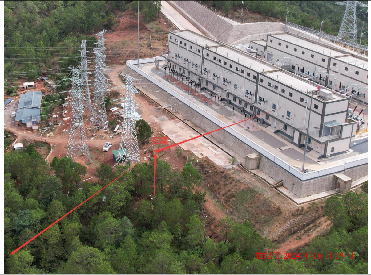
220kV 苍岭变出线现状 (线路起点)
