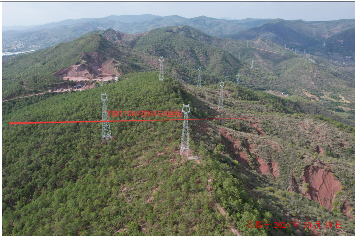
线路穿越 110kV 苍科 I 回与 I 回线交叉点现状 (N16~N17)
