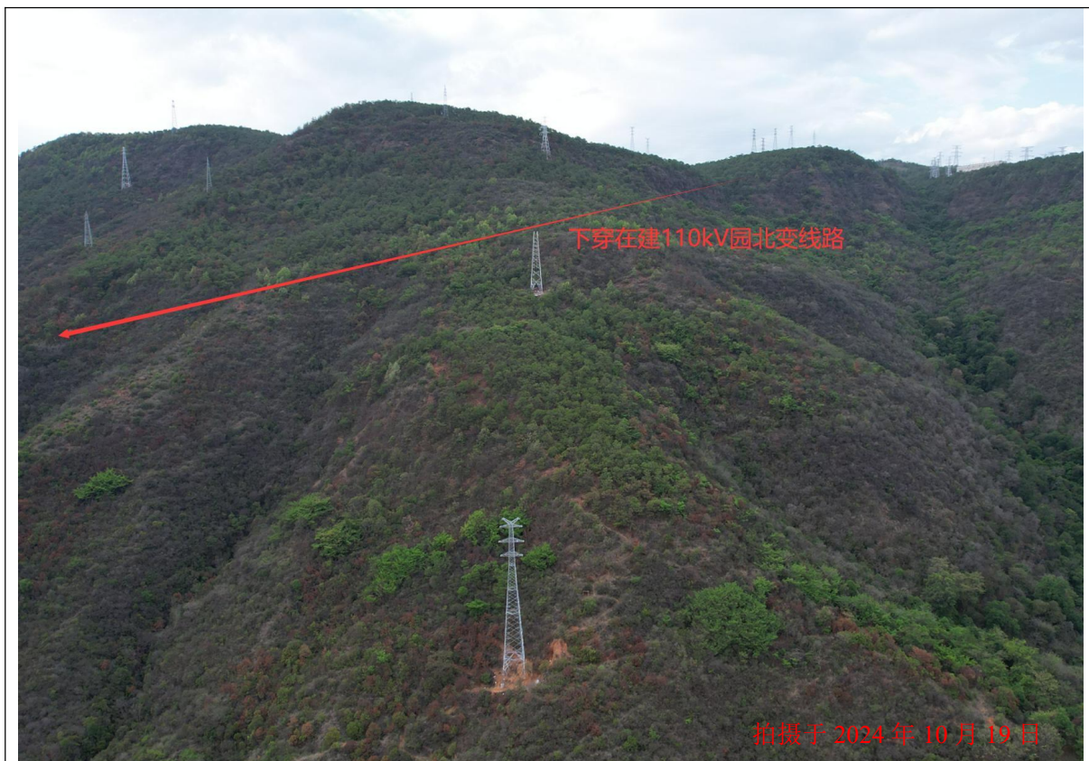
线路与在建 110kV 园北变线交叉点现状 (N4~N5)
