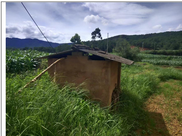
(1) 项目区上游汗排村水井
