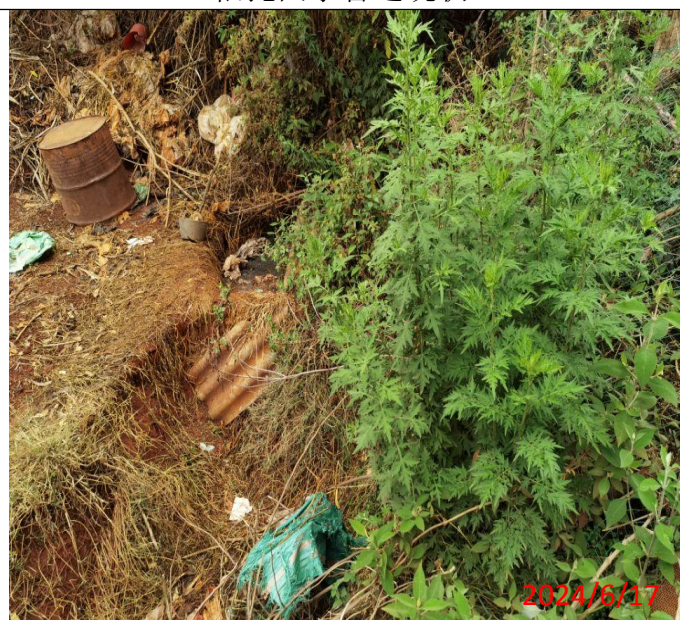
原有化粪池现状
