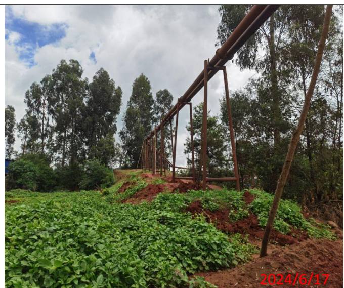
拟建项目浆料输送管道现状
