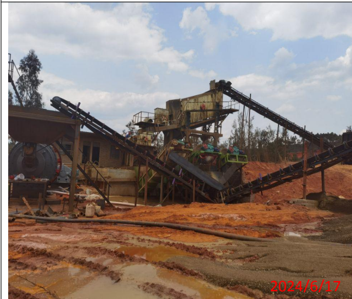
拟建项目原料制浆场地现状
