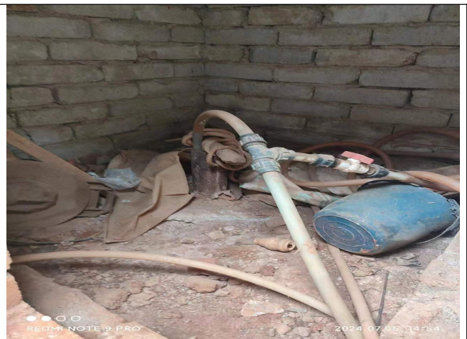
(2) 尾矿库大坝下游摆衣龙潭水井
