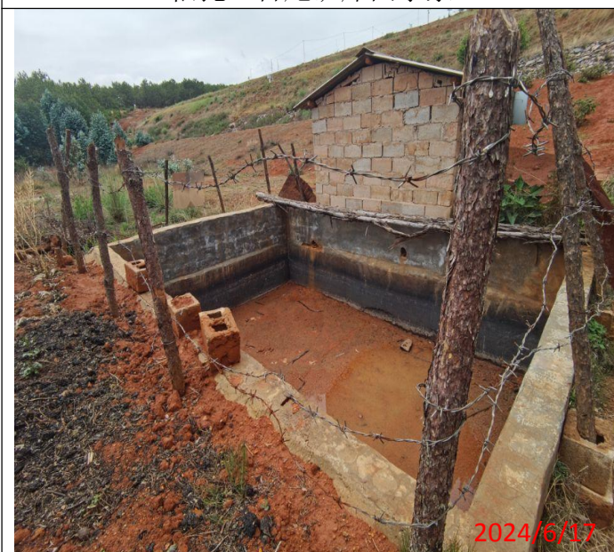
尾矿库坝下应急水池现状
