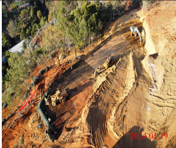
马头地光伏 110kV 升压站现状（在建）
