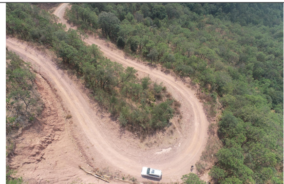
场内改扩建道路
