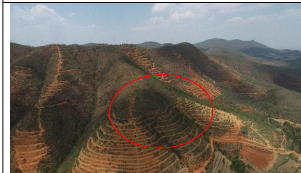
4#-5#光伏阵列航拍
