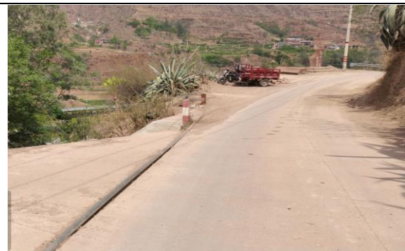
现有进场道路
